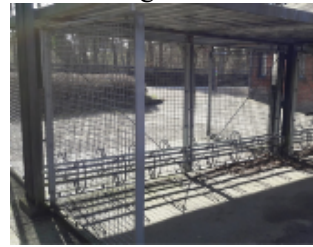
Overdækket cykelparkering Marts 2020 Fredensborg Station
