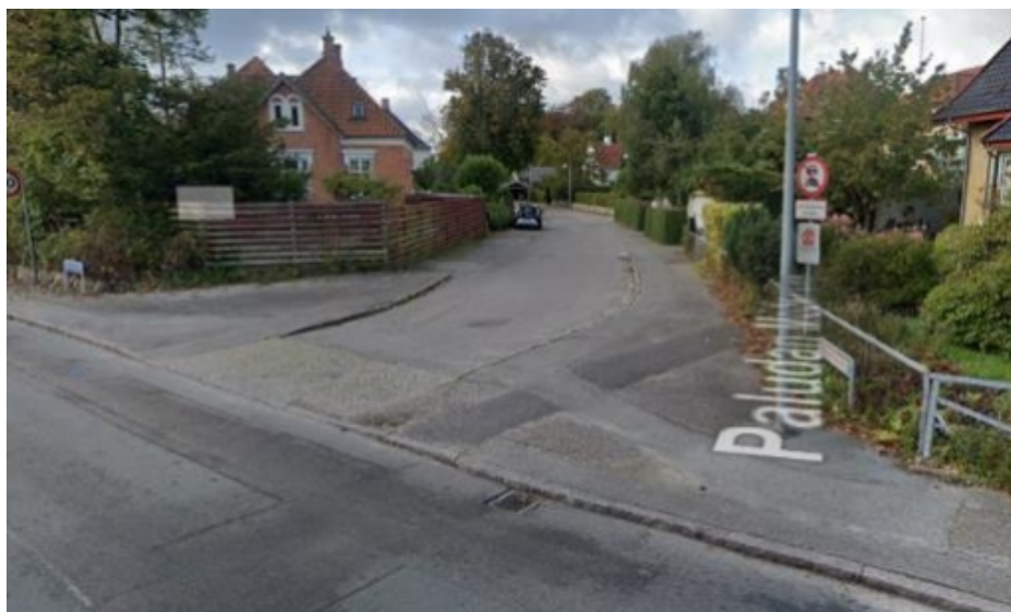
Foto før ændring. Overkørsel med chaussésten ved Paludan Müllersvej (2019)
