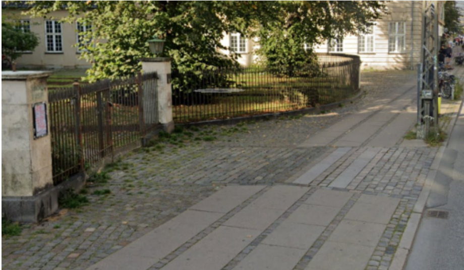
Referencefoto Vesterbrogade, København – Overkørsel i brosten og bordurstensbånd
